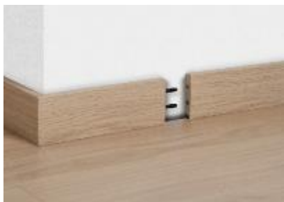
Verbinding van 2 plinten langs de muur
